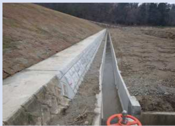
完 成 (法尻水路)
