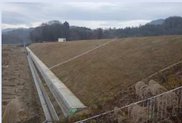
完 成 (法尻水路)
