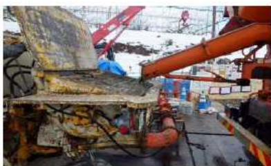
管理立坑からの高圧P打設状況
