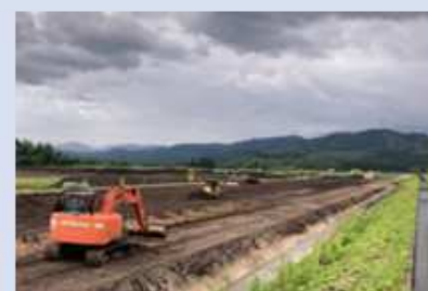
施工体制の充実化（重機確保）
