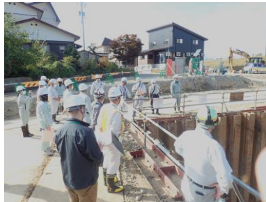
〈国交省 治水工事〉
