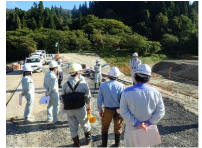
〈角間沢ため池工事〉
