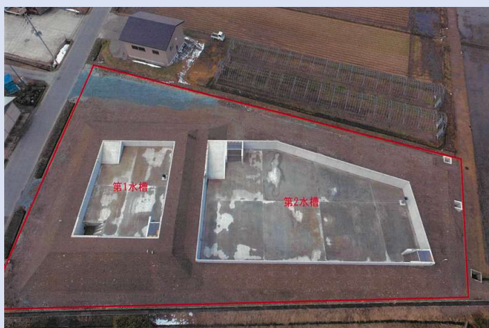
完 成（調整水槽工）
