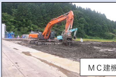
I C T 施 工 (中層混合処理)
