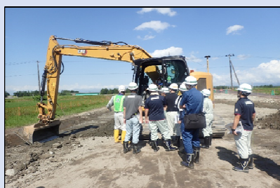
I C T 施工現場研修会
