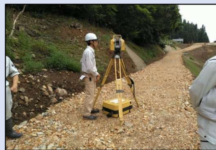
TLSによる起工測量
