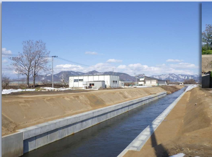
完 成 (排水路工)
