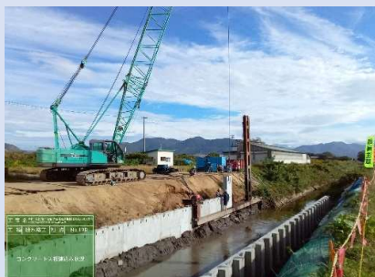
打ち込み施工状況
