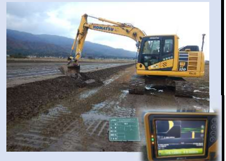
I C T 機 械 施 工
