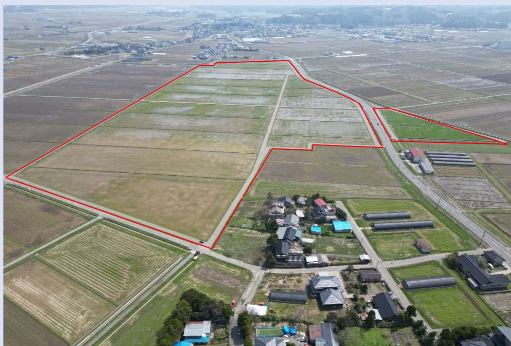
完 成（区画整理工）
